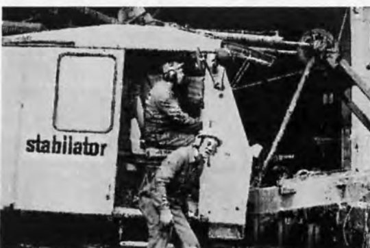
Pålning av den nya spårhallen
