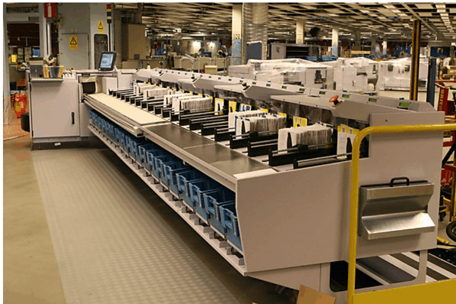
En av de första BFM:arna installerad på Malmöterminalen.
