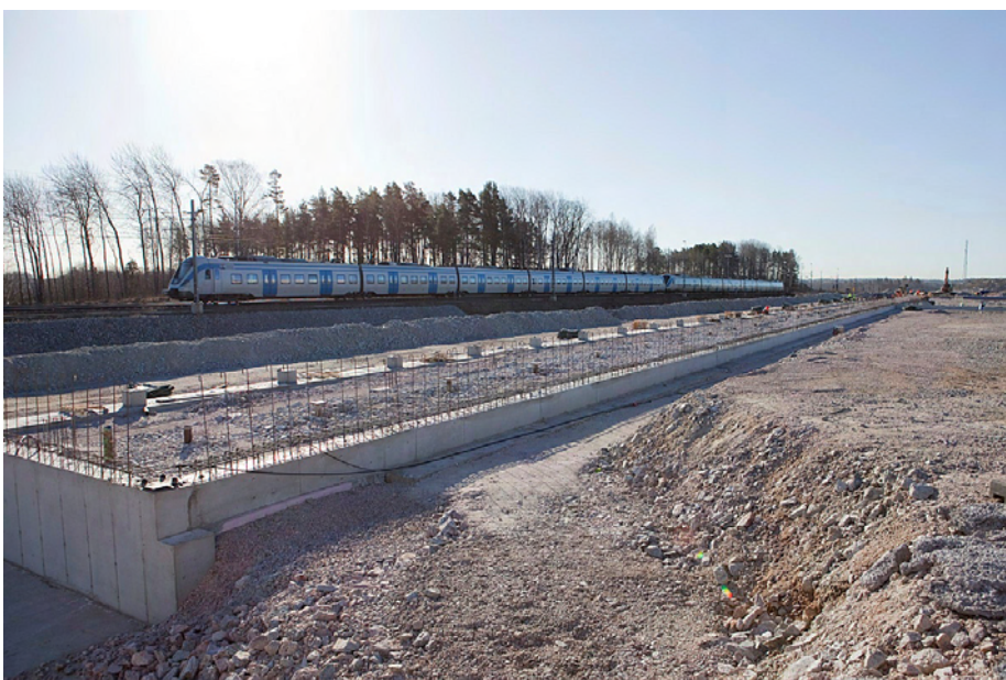
Rosersberg den 3 april 2013. Överst: byggnaden från norr. Mitten: från sydväst. Nederst: blivande spårhall.
